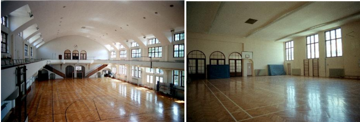
Halle 1 und Halle 2 nach der Gebäudesanierung 1987 (Archiv MTV München).
