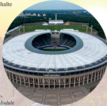
[Bild des Olympiastadion Berlin – folgende Bildunterschrift möglich: 1.614 PV-Module auf dem äußeren Betonring des Stadionsdachs erzeugen rund 615.000 Kilowattstunden Strom im Jahr. Das spart jährlich rund 225 Tonnen CO2.]
